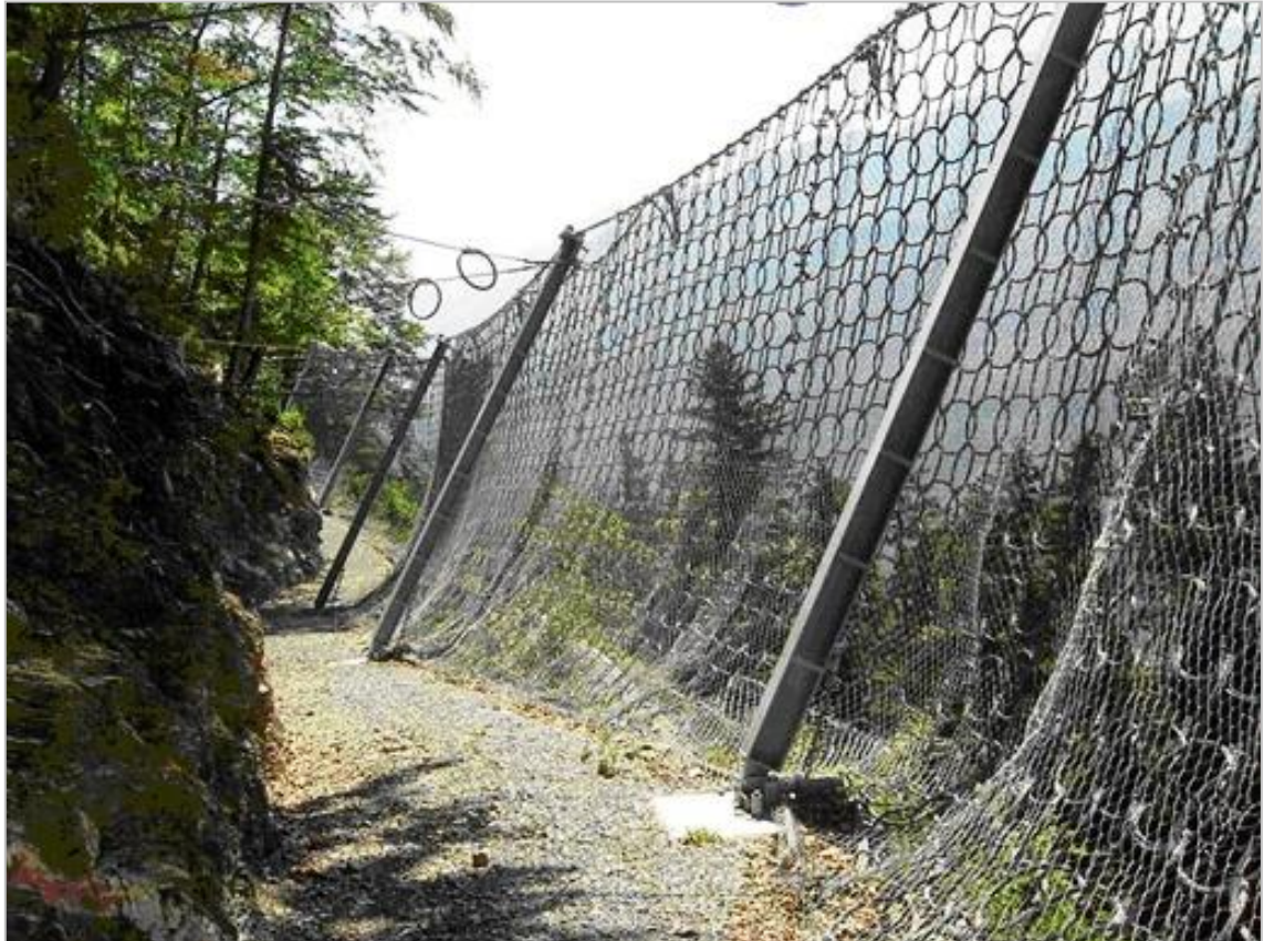
Figura 1: Rete paramassi lungo la tratta del Brünig con via di accesso per la manutenzione
